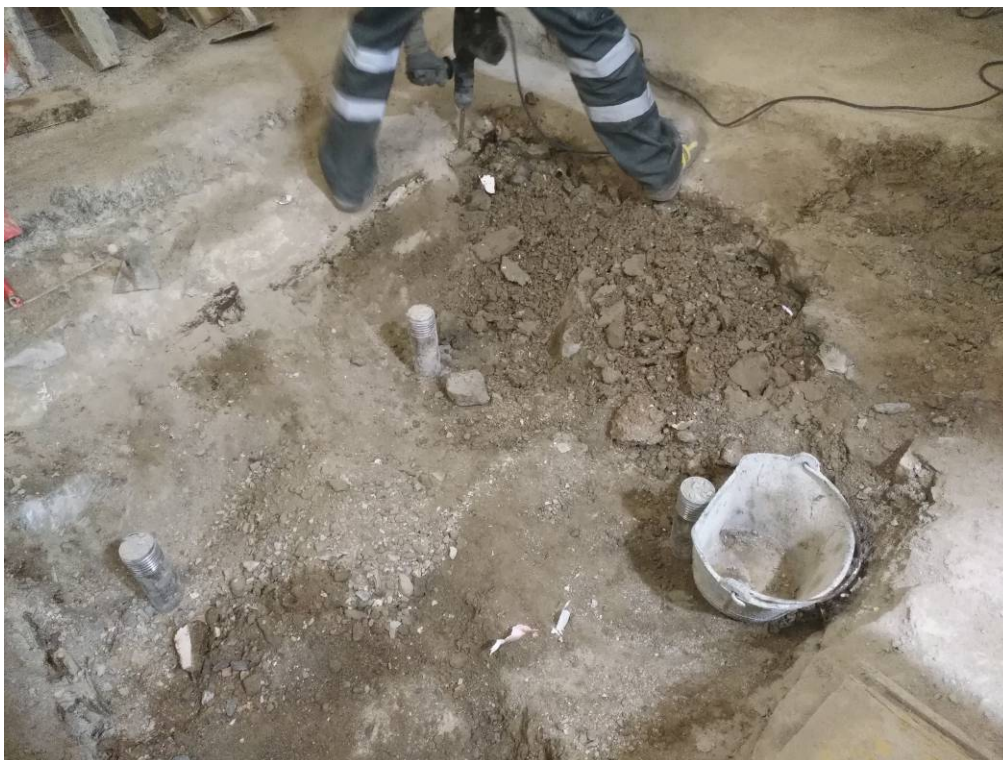
Foto 3: Tasques de demolició del paviment UE 1
