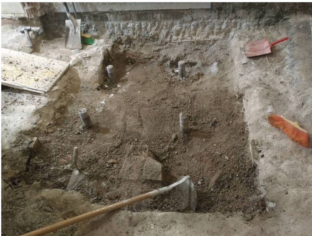
Foto 4: Treballs de demolició del paviment UE 1
