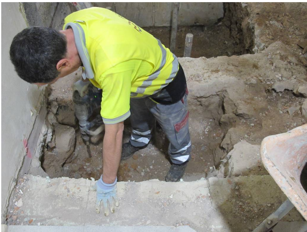
Foto 23: Eliminació del mur UE 4
