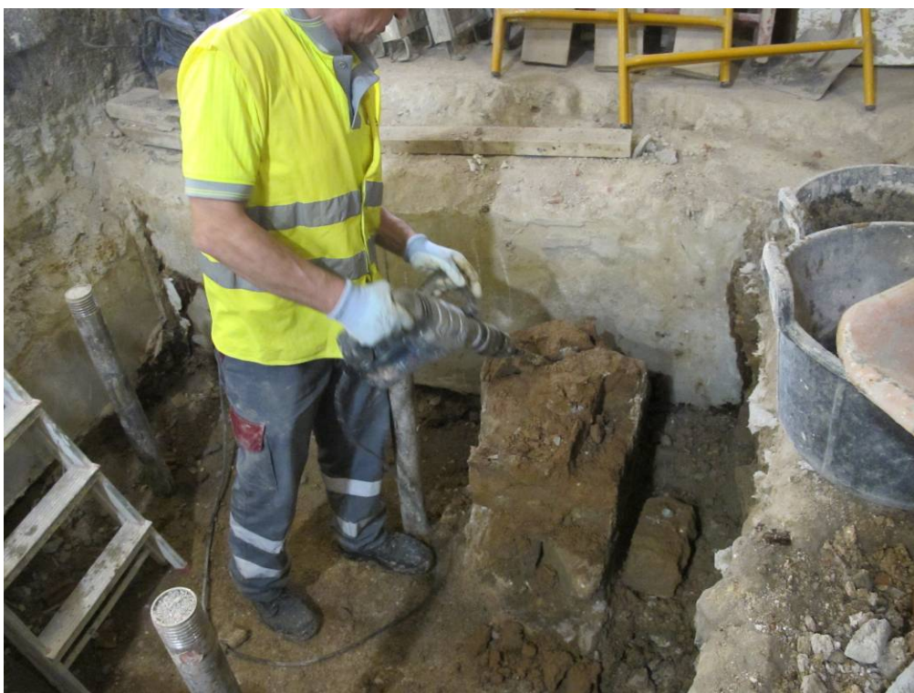
Foto 22: Eliminació del mur UE 3
